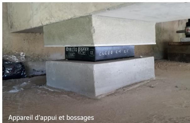
Appareil d'appui et bossages
